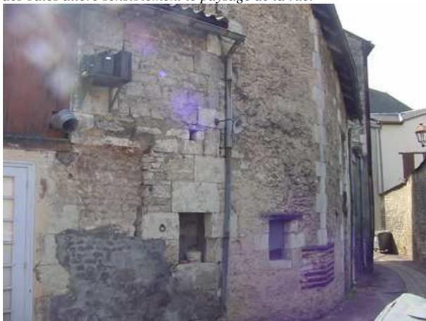
*L'enduit ou le jointoiement au ciment sont interdits.*
