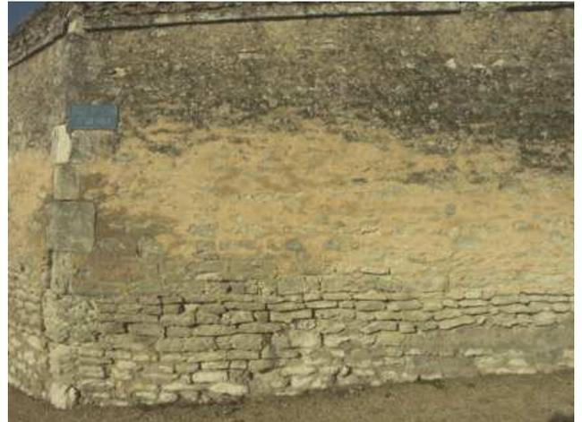
*Un mur à pierre apparente est bien souvent le résultat de l'érosion de l'enduit qui les protégeait.*
