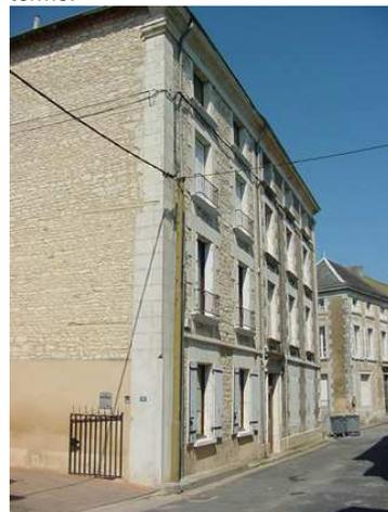
*Les remplissages de petite pierre entre les chaînages doivent être enduits.*
