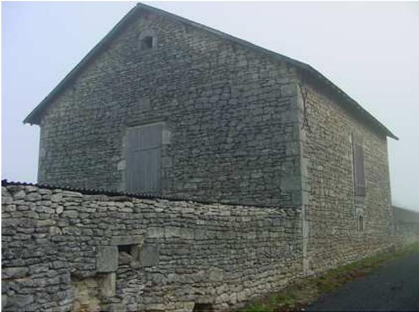
*Bien que faits pour être enduits...les murs moellonnés sont remarquables par la qualité de la pose des pierres, la régularité des lits et leurs rapports aux chaînages*
